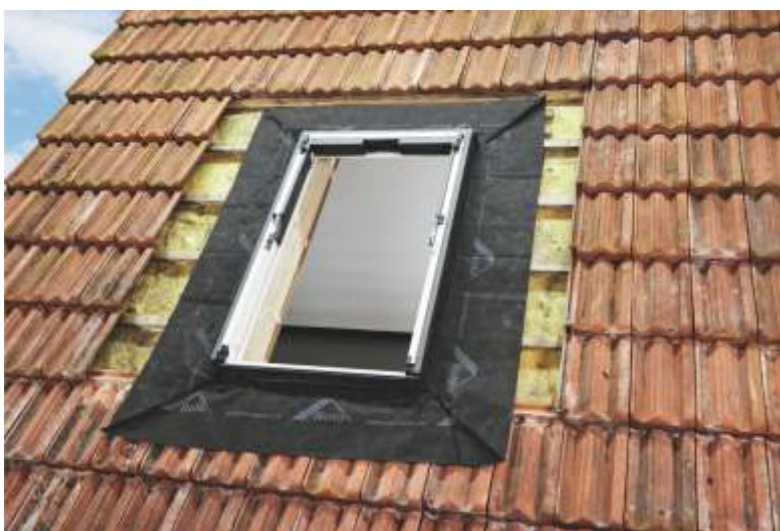
Гидроизоляционный фартук - гидро- и ветроизоляция ASA
